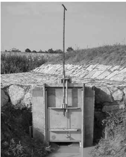
Bild 2: Drosselschieber im Einsatz
